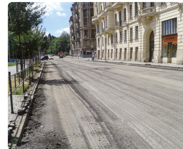
Oprava povrchu vozovky na ulici Úvoz, úsek Tvrdého-Veverí.
