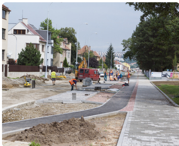
Rekonstrukce inženýrských sítí a silnice ulice Dobrovského.
