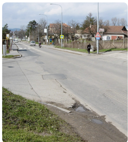
Křižovatka Kaštanová – Popelova před rekonstrukcí.
