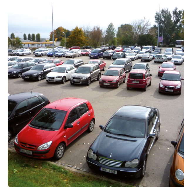
Stávající stav parkoviště před rekonstrukcí.
