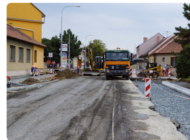
Rekonstrukce komunikací Tuřany II.
