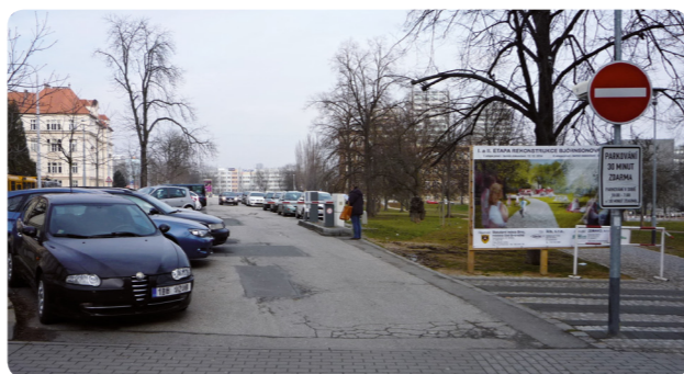
Parkoviště Veverí – celkem 140 míst.
