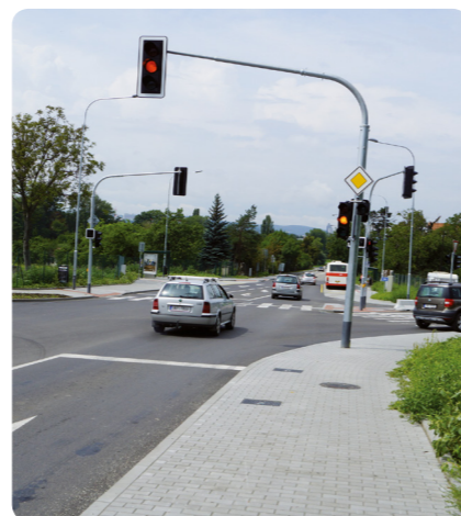
Křižovatka Kaštanová – Popelova po rekonstrukci.
