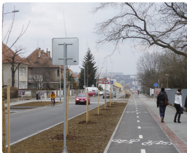
Ulice Dobrovského po rekonstrukci.
