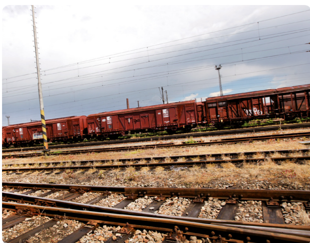
Seřadovací stanice Brno-Maloměřice patří k nejvýznamnějším na síti SŽDC.
