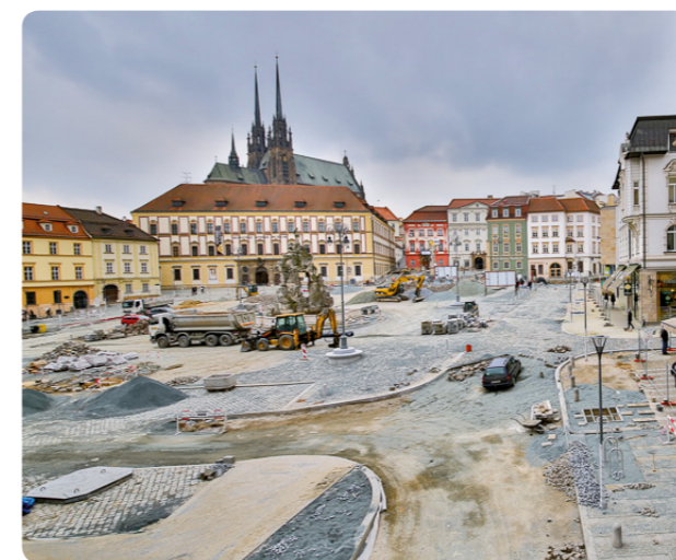
Zelný trh v průběhu rekonstrukce.
