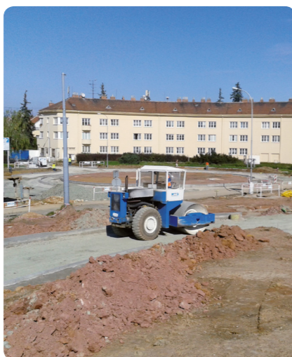
Vaňkovo náměstí během rekonstrukce.
