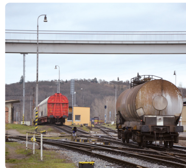
Seřadovací stanice Brno-Maloměřice patří k nejvýznamnějším na síti SŽDC.
