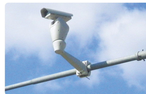
Křižovatka SSZ s kamerovým dohledem – Otakara Ševčíka.
