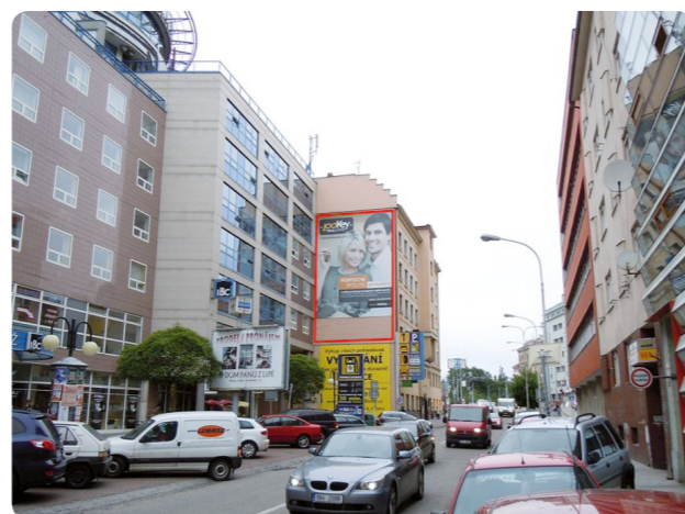
Parkovací dům IBC Příkop.
