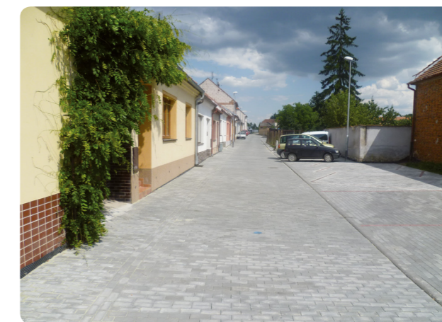
Komunikace Tuřany II po rekonstrukci.
