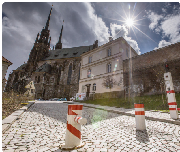
Ukázka profilu zádržného systému na ulici Biskupská.
