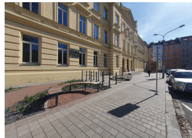
Rekonstrukce chodníku před budovou ZŠ Antonínská.
