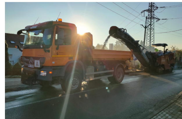
Frézování asfaltobetonového povrchu komunikace.
