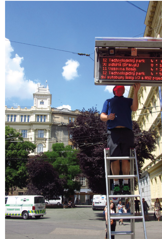
Pracovníci KORDIS opravují informační panely na přestupním uzlu Česká.
