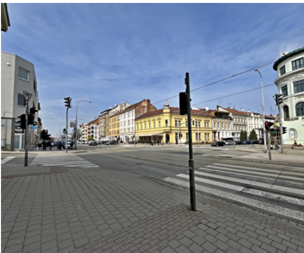
Křižovatka 8.01 Minská – Tábor, rekonstrukce světelné signalizace je součástí projektu Rozvoj ITS v Brně, 3. etapa.
