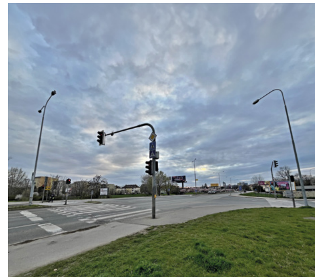
Křižovatka 3.21 Černovická – Černovické nábřeží, rekonstrukce světelné signalizace je součástí projektu Rozvoj ITS v Brně, 1. etapa.
