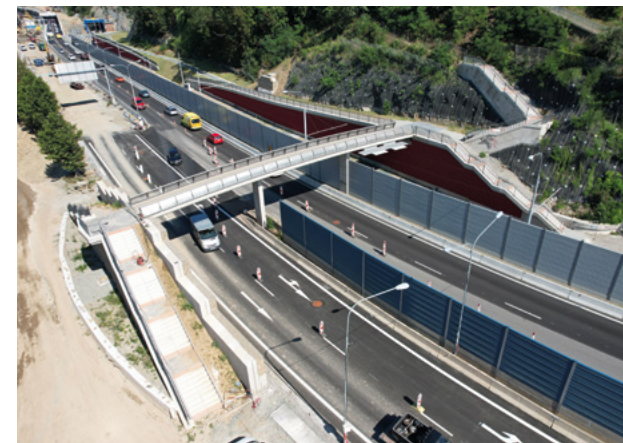
I/42 Brno, VMO Žabovřeská – etapa II.
