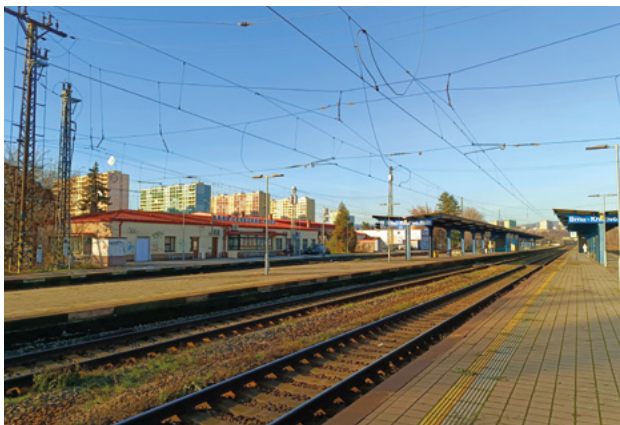
6. prosince 2023 byla zahájena rekonstrukce železniční stanice Brno-Královo Pole.
