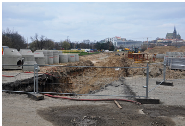
Budování ulice Uhelná.
