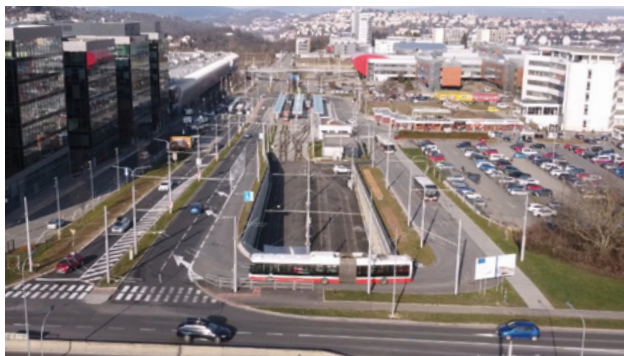
Tramvajová trať Kampus – celkový pohled na terminál Kampus.
