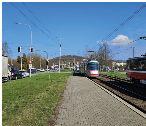
Rekonstruovaná křižovatka se SSZ Kníničská – Bystrcká.
