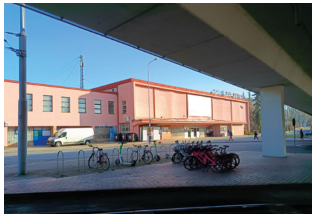
Rekonstrukce železniční stanice Brno-Královo Pole bude znamenat totální přeměnu stávající stanice a zánik podoby, ve které ji Brňané znali více než 50 let.
