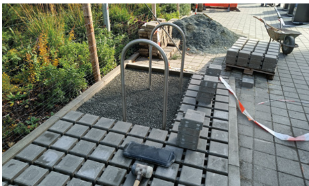
Budování stojanů na kola.
