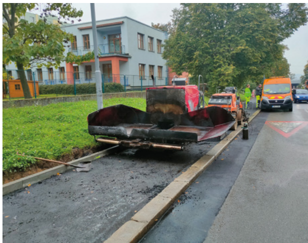
Pokládka nového povrchu chodníku.
