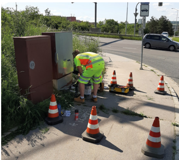
Applikace ochranného nátěru řadiče SSZ.
