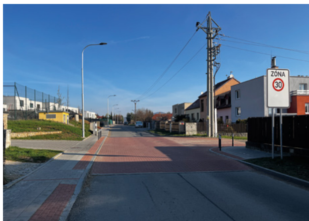
Rekonstrukce komunikace ulice Hatě.
