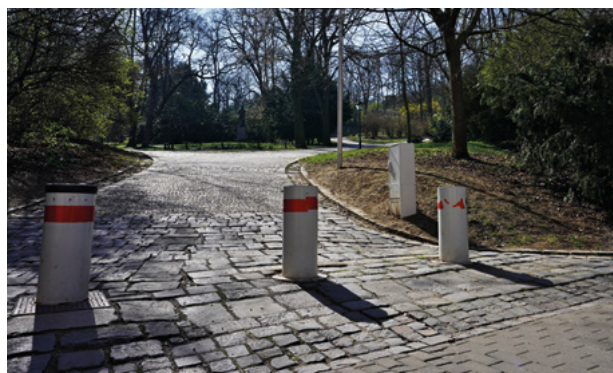
Ukázka profilu zádržného systému Údolní - Špilberk.
