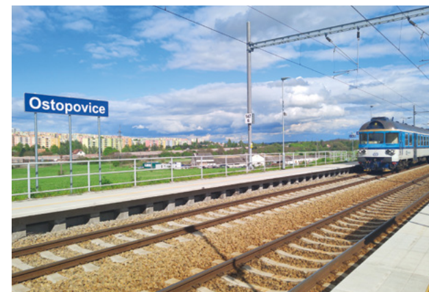
Nová železniční zastávka v Ostopovicích.
