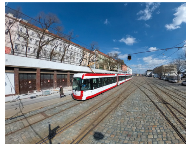
Kolejové propojení v ulici Nádražní.
