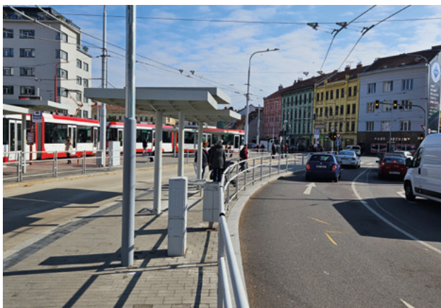
Rekonstruovaná křižovatka se SSZ Mendlovo nám. - Křížová.
