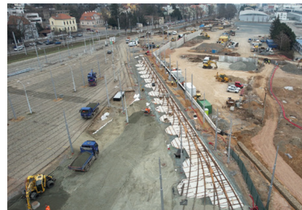
Realizace projektu vratné smyčky Pisárky pokládka nové kolejové sjezdové harfy.
