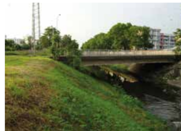
Podjezd Hladíkova před realizací.
