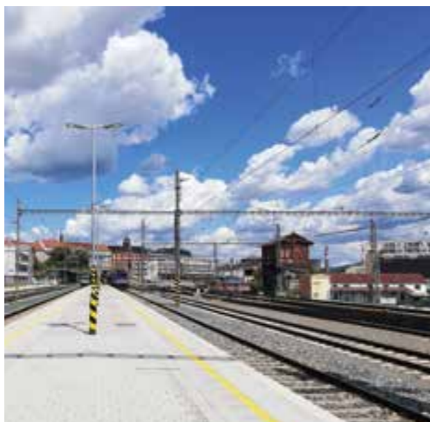
Hlavní nádraží v posledních letech prochází rekonstrukcí. Po modernizaci nástupišť byla v roce 2022 dokončena oprava levého křídla výpravní budovy a začala oprava pravého křídla.
