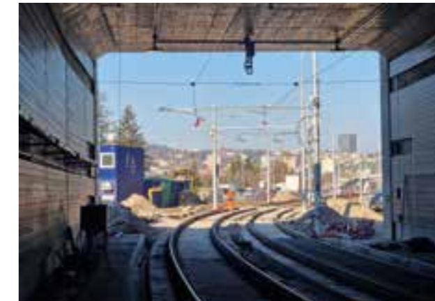
Severní portál tramvajového tunelu.
