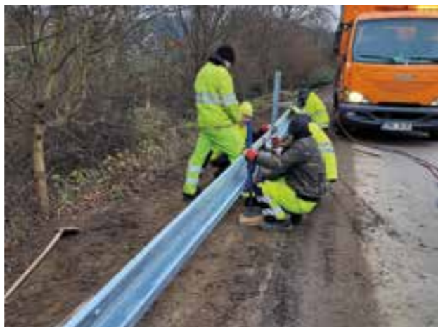
Oprava bezpečnostních svodidel.
