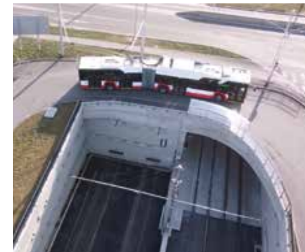
Tramvajová trať kampus – pohled na severní portál tunelu.
