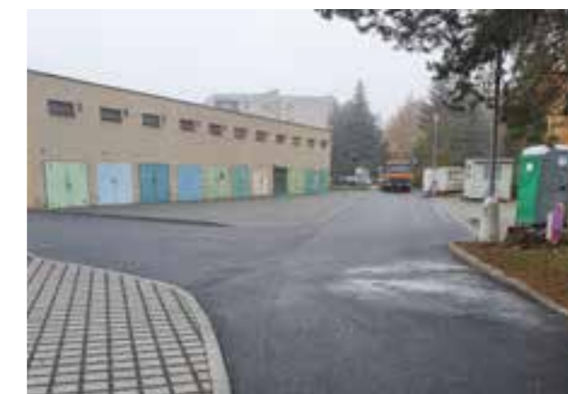
Ulice Vyškovská po opravě komunikace.
