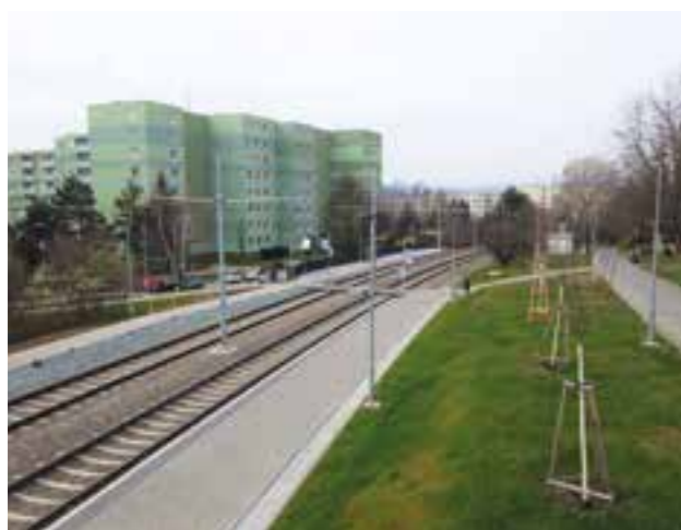
Nová tramvajová zastávka Karpatská.
