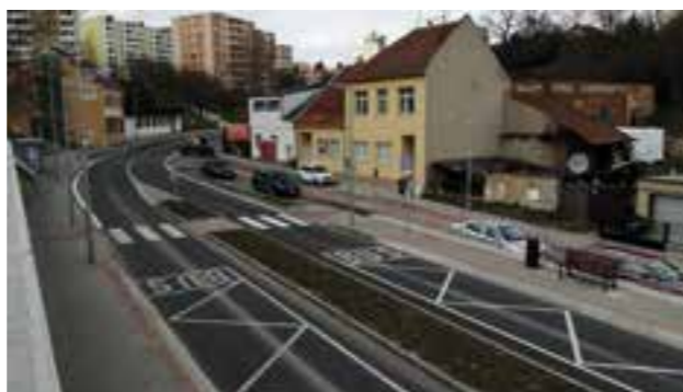
Ulice Návrší Svobody – úprava zastávky MHD Výletní.
