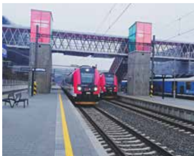
Součástí rekonstrukce tratě Brno – Blansko byla i modernizace nádraží v Adamově. To bylo vybaveno novou architektonicky zdařilou lávkou.
