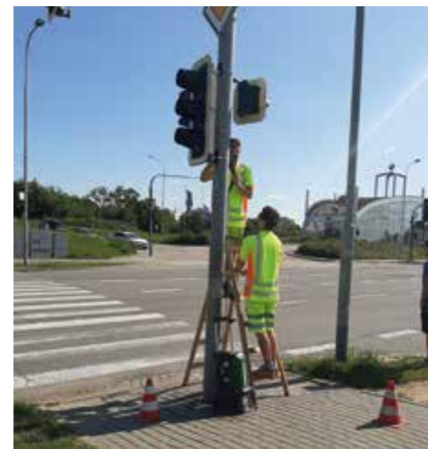
Instalace světelného signalizačního zařízení (SSZ).
