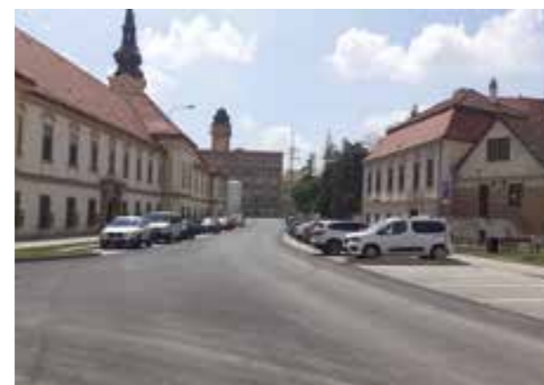
Ulice Lazaretní po rekonstrukci.
