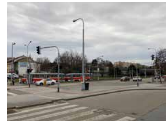
Křižovatka 2.63 Vídeňská - Strážní, rekonstrukce světelné signalizace je součástí projektu Řízení dopravy a sběr dopravních dat ve městě Brně, 6. etapa.
