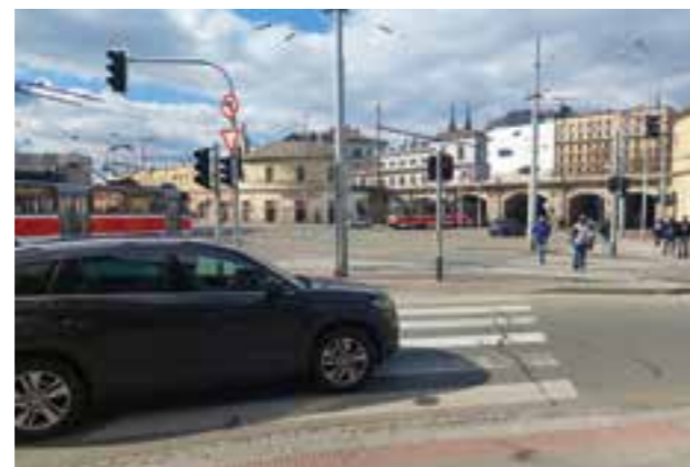
Rekonstruovaná křižovatka se SSZ Koliště - Křenová.
