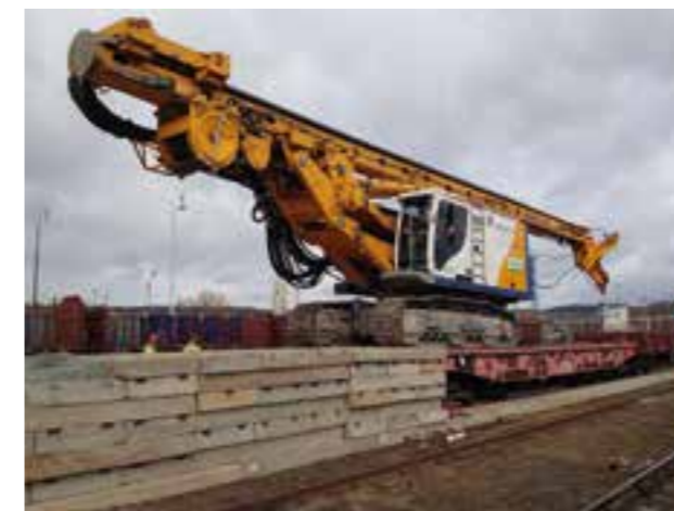
Přesun těžké vrtné soupravy v Brně-Maloměřicích.
