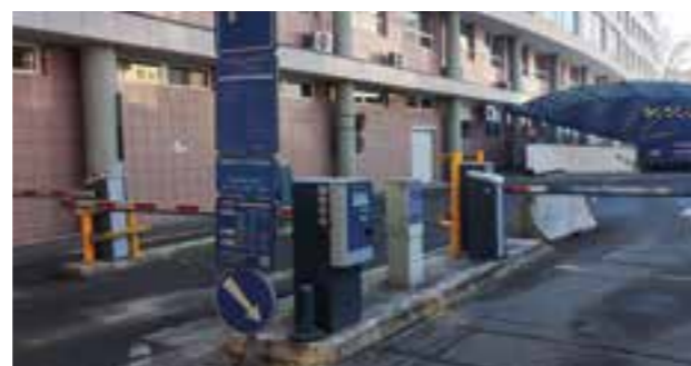
Parkovací dům IBC Příkop.
