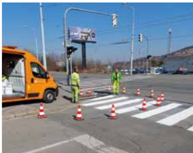
Pokládka vodorovného dopravního značení (VDZ).
