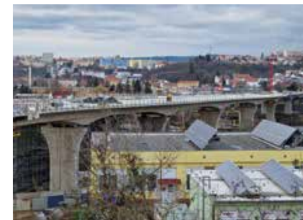
Estakáda nad ul. Kulkova a maloměřickým nádražím.
