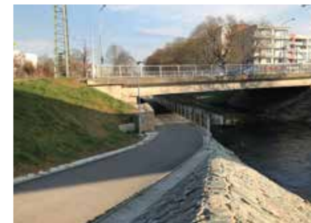
Podjezd Hladíkova po realizaci.
