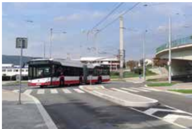
Trolejbusová trať pod tramvajovým mostem u výstaviště.
