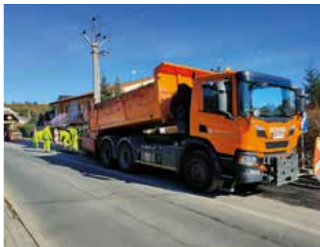
Pokládka balených asfaltových směsí.
