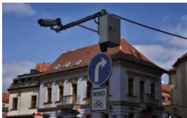
Kamerový systém pro monitorování vjezdu do zón s dopravním omezením - profil Šilingrovo náměstí.
