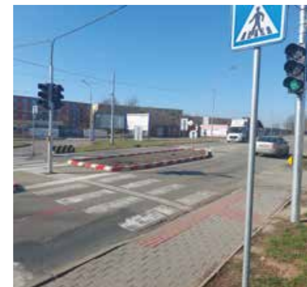
Nově vybudovaný světelně řízený přechod pro chodce na ulici Hvězdoslavova, Brno-Slatina.
