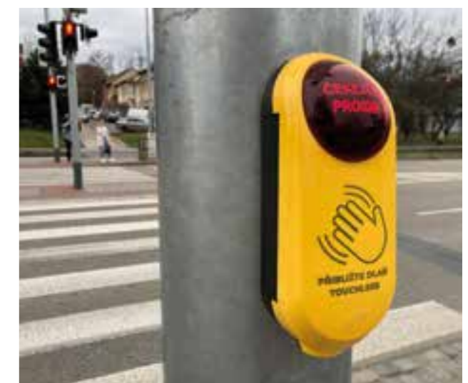
Bezdotykové tlačítko pro chodce na křižovatce 2.63 Vídeňská - Strážní, jehož instalace byla součástí projektu Řízení dopravy a sběr dopravních dat ve městě Brně, 6. etapa.
