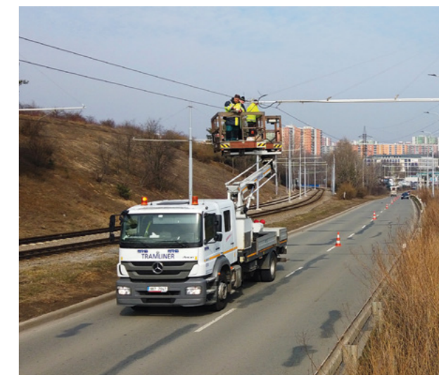
Výstavba trolejbusové tratě v ulici Jedovnická.
