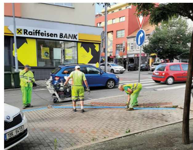
Pokládka VDZ - oblast placeného stání.
