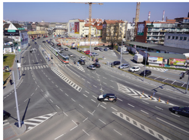
Křižovatka 3.12 Dornych – Úzká, rekonstrukce světelné signalizace vč. doplnění kamerového dohledu je součástí projektu Řízení dopravy a sběr dopravních dat ve městě Brně, 5. etapa
