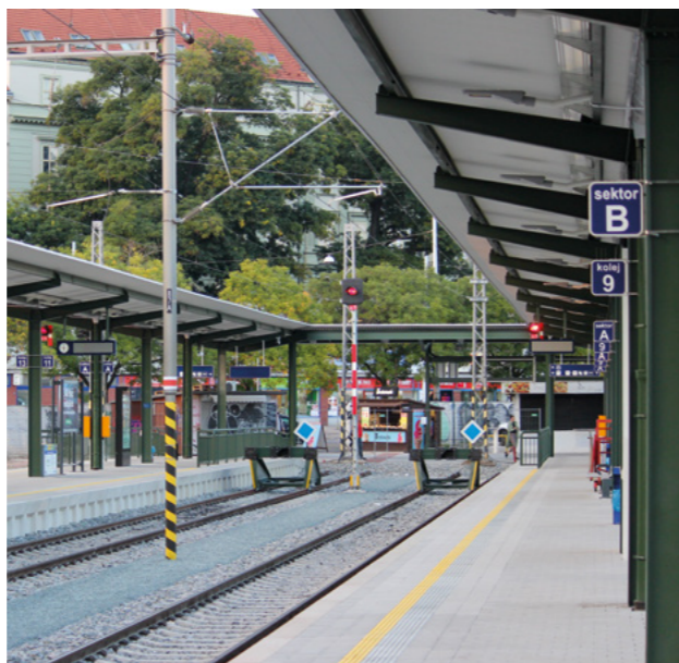
V roce 2021 proběhla poslední etapa rekonstrukce nástupišť brněnského hlavního nádraží. 5. a 6. nástupiště bylo zvýšeno a nově zastřešeno.
