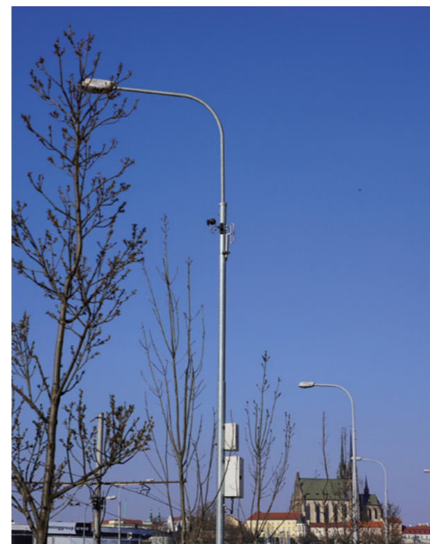
Ukázka videodetektoru na Renneské třídě.
