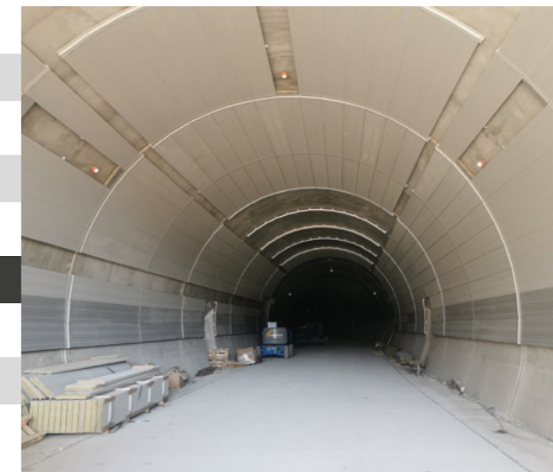
Tramvajový tunel, zahájení montáží protihlukového obkladu.
