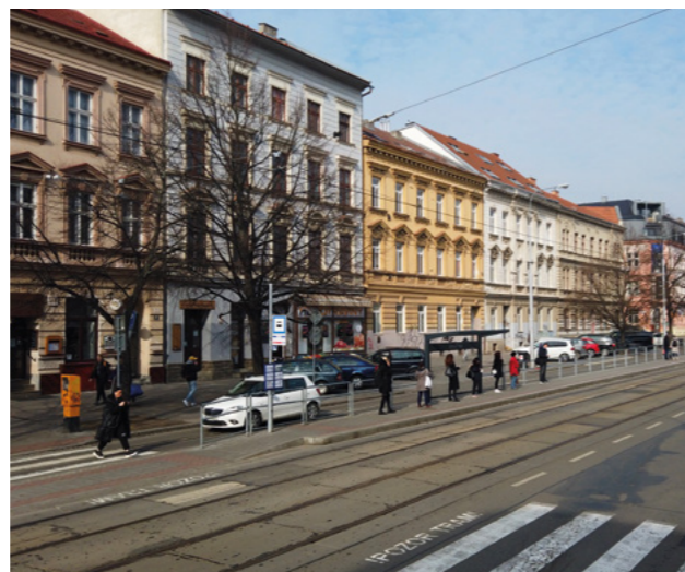
Bezbariérová nástupiště v zastávce Hrnčířská (ulice Štefánikova).
