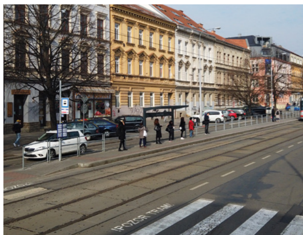
Bezbariérová úprava zastávky Hrnčířská.
