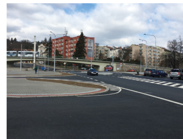
Ulice Křížkovského, nově zrekonstruovaný chodník a komunikace.
