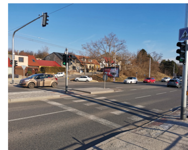
Nově vybudovaná křižovatka se SSZ – přechod Podstránská.
