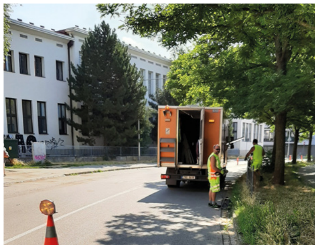
Opravy bezpečnostního zábradlí.
