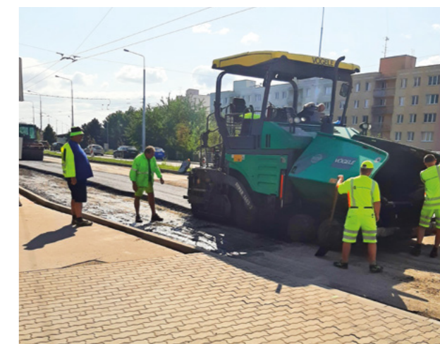
Pokládka balených asfaltových směsí.
