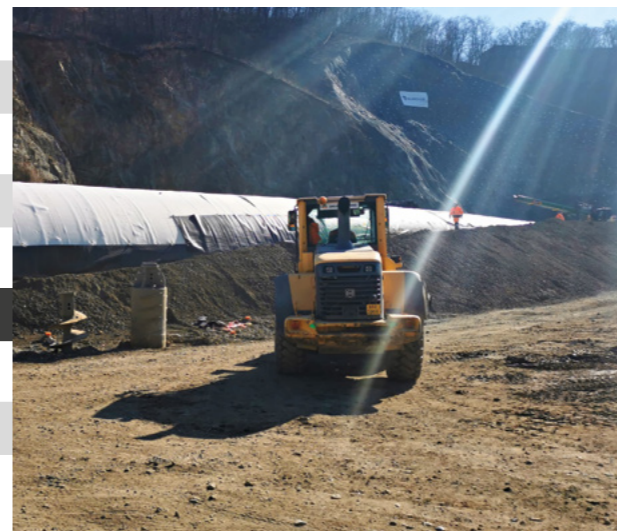
Pohled na zásyp tramvajového tunelu.
