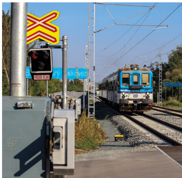
Na konci roku 2021 byla zprovozněna nová železniční zastávka Brno-Starý Lískovec. Dočasně je obsluhována jen několika vlaky denně. Po vybudování nového terminálu a dokončení elektrizace tratě do Zastávky získá velký význam nejen pro obyvatele přilehlých ulic, ale i pro návštěvníky Univerzitního kampusu a bohumické nemocnice.
