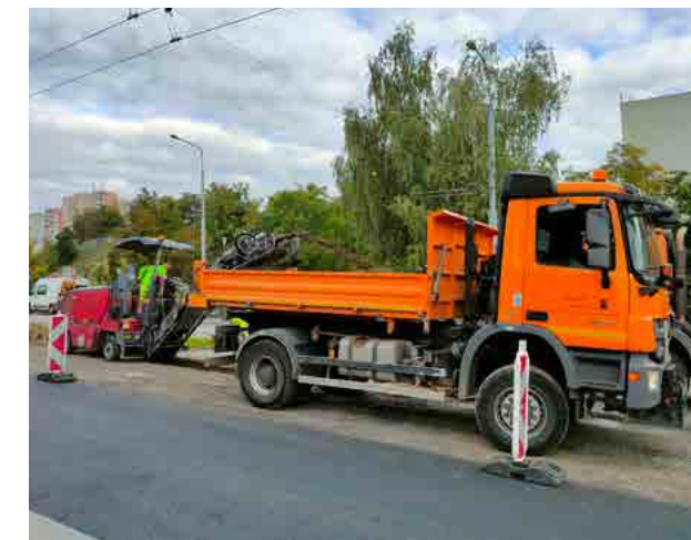
Frézování povrchu vozovky silniční frézou W 50 DC.
