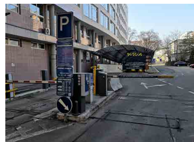
Parkovací dům IBC Příkop.
