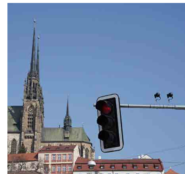
Návěstidlo SSZ a videodetektory SSZ na křižovatce Hybešova - Nádražní.
