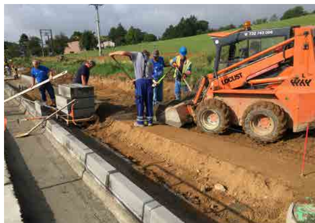
Stavební práce na novém chodníku na ulici Blanenská.
