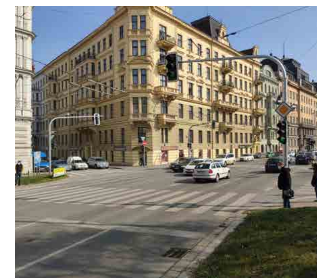
Rekonstruovaná křižovatka se SSZ Koliště – Bratislavská. V roce 2020 byly v návaznosti rekonstrukce SSZ i na křižovatkách Příkop – Bratislavská (vlevo) a Koliště – Cejl (rovně).
