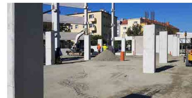
Stavba parkovacího domu na ulici Polní.
