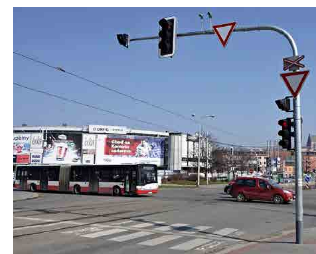
Křižovatka 2.02 Poříčí – Nové Sady, rekonstrukce světelné signalizace je součástí projektu Řízení dopravy a sběr dopravních dat ve městě Brně, 3. etapa.
