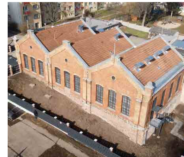
Objekt měřírny Královo Pole.
