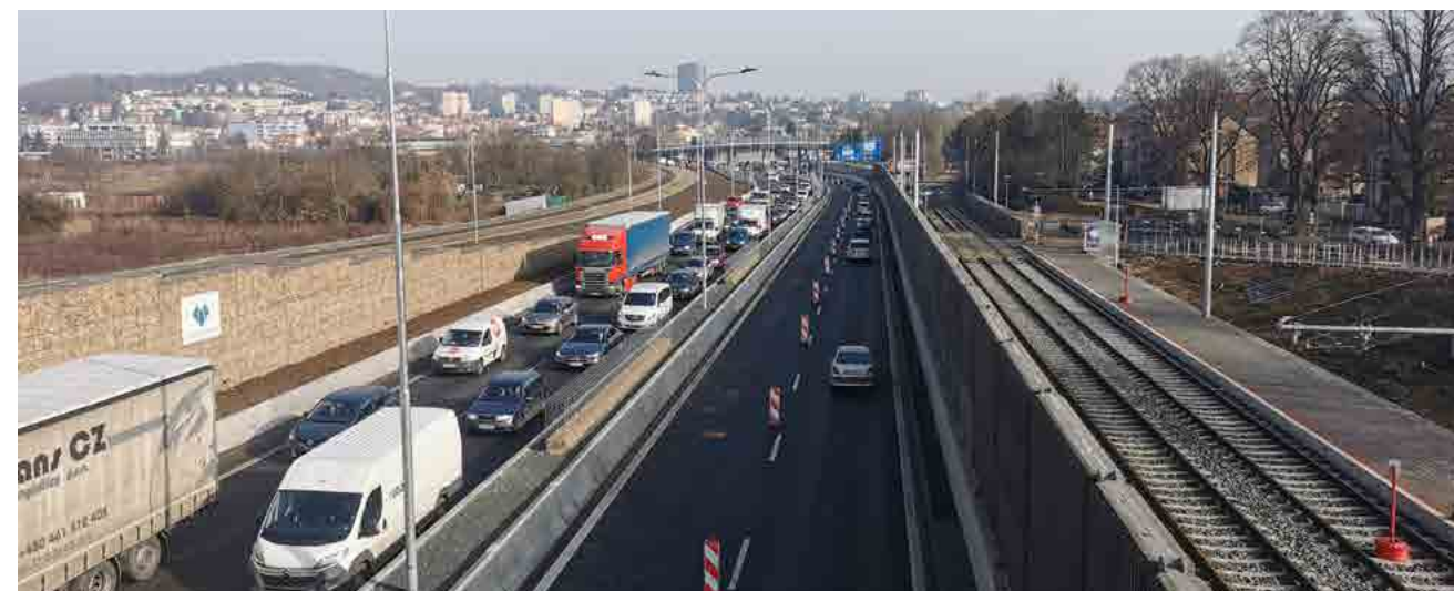
Nově dokončený úsek VMO.
