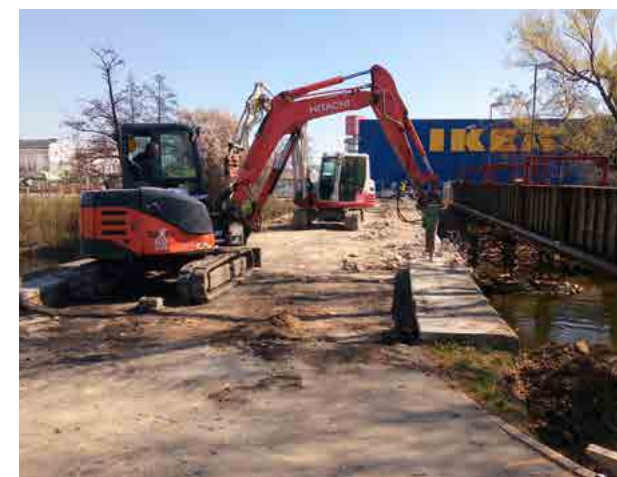
Demolice stávajícího mostu s provizorní lávkou vpravo.
