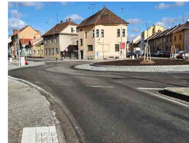
Okružní křižovatka Charbulova – Řehořova – Húskova – Štolcova po dokončení prací.
