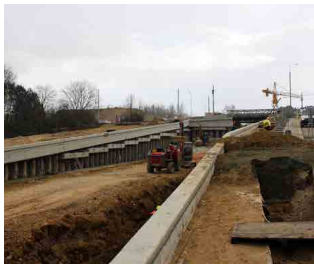
Staveniště budoucího výjezdu z tunelu před stanicí Kampus, terminál.
