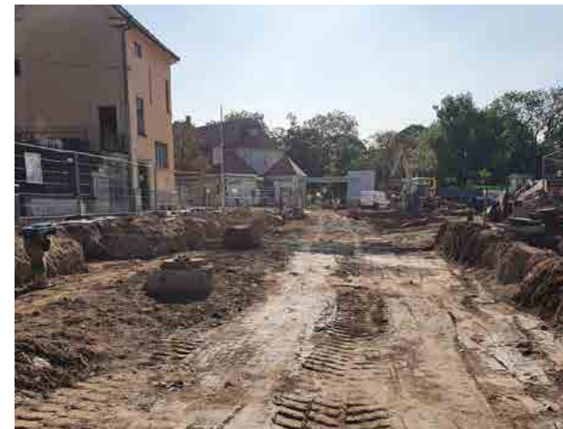
Výstavba vozovky na ul. Charbulova.
