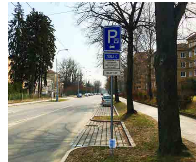
Ulice Chodská po rekonstrukci.
