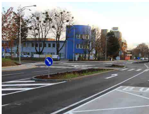
Ulice Bohunická po dokončení prací.
