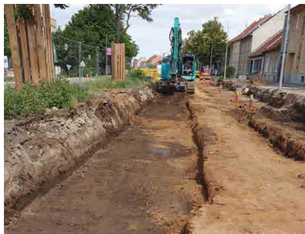
Stavební práce na ulici Bohunická.
