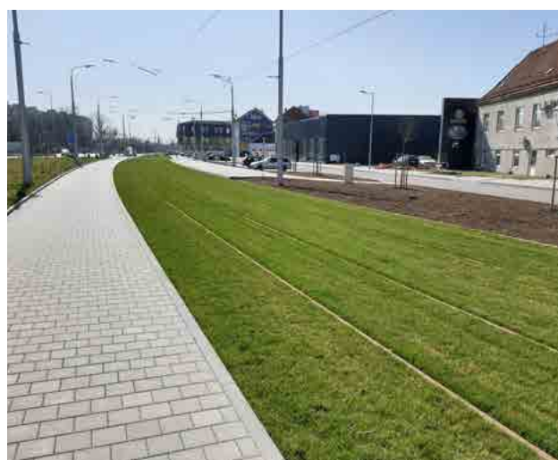
Dokončená tramvajová trať na ulici Plotní.
