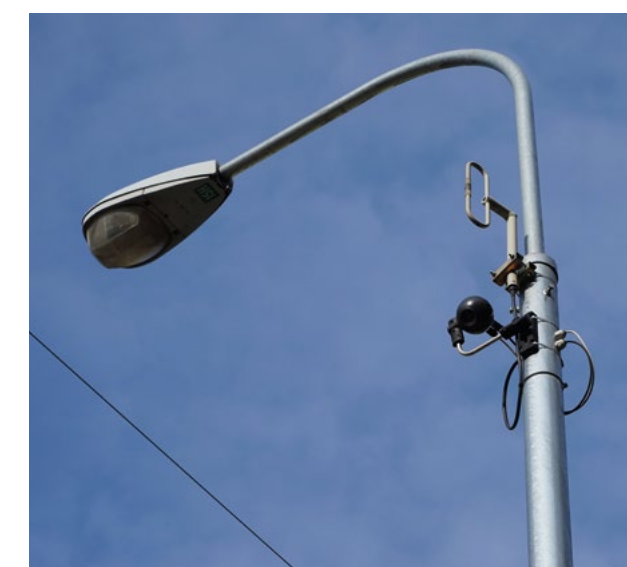
Ukázka videodetektoru na ul. Úvoz.
