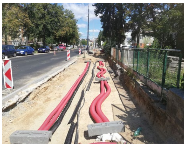
Parkování a chodníky na ulici Chodská - přeložka VO.
