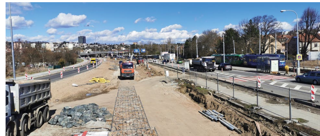
Stavební práce na ulici Žabovřeská.
