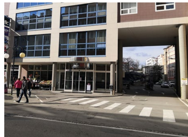
Parkovací dům IBC Příkop.
