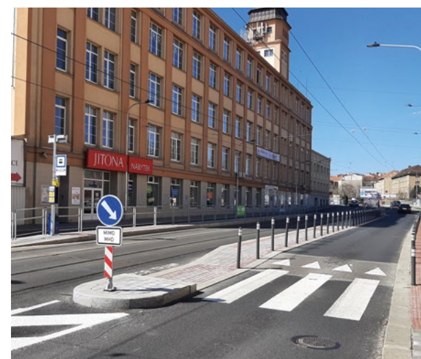
Tramvajová trať v ulici Cejl, zastávka Vojenská nemocnice.
