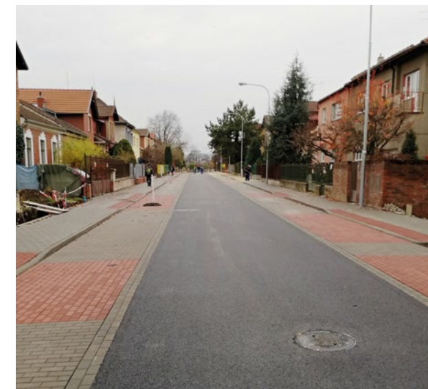
Ulice Muchova po dokončení prací.
