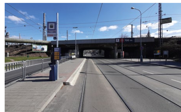
Bezbariérová úprava zastávky Kuldova.
