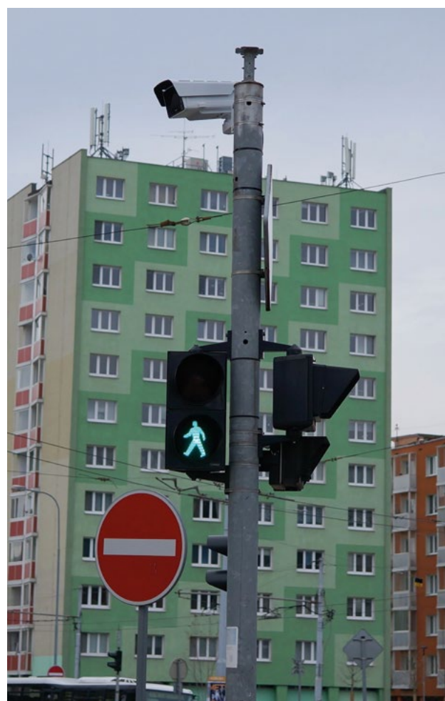
Kamerový dohled na křižovatce Mendlovo nám. - Křižová.
