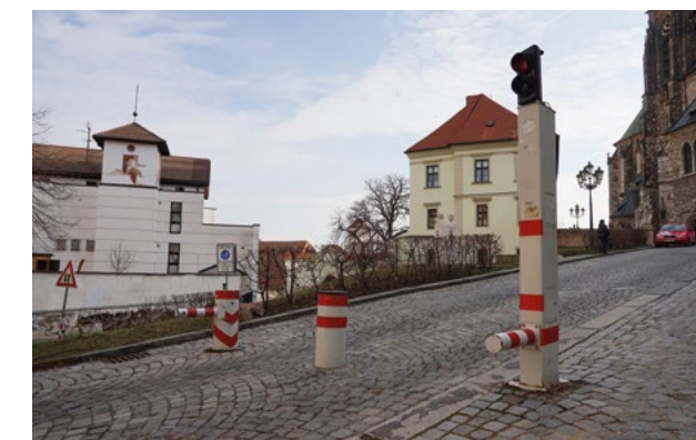
Ukázka profilu zádržného systému na ulici Petrov.
