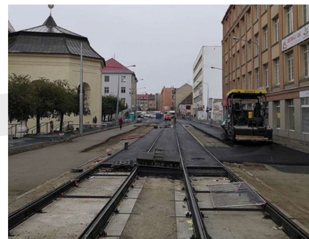
Odhlučnění tramvajové tratě Cejl – Zábřdovická.
