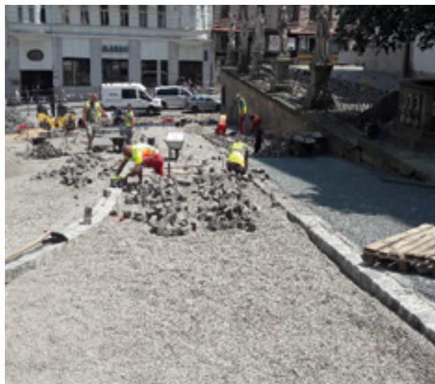
Stavební práce při rekonstrukci Dominikánského náměstí.
