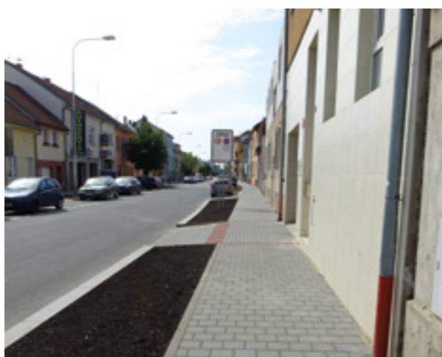
Chodník na ulici Poděbradova – dokončení.
