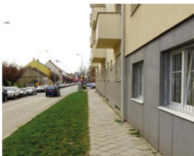
Chodník na ulici Poděbradova – původní stav.
