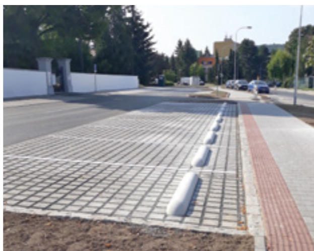
Parkoviště na ulici Absolonova po dokončení.
