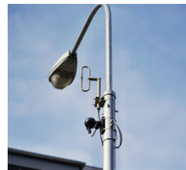
Ukázka videodetektoru na ul. Úvoz.
