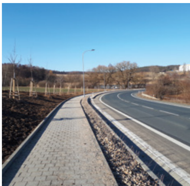
Chodník na ul. Hostislavova po dokončení.
