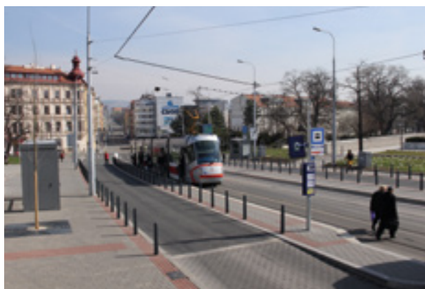
Bezbariérová úprava zastávky Moravské náměstí.
