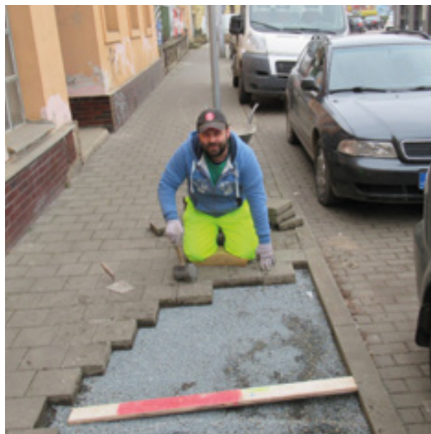
Dlaždičkové práce - předložba chodníku.
