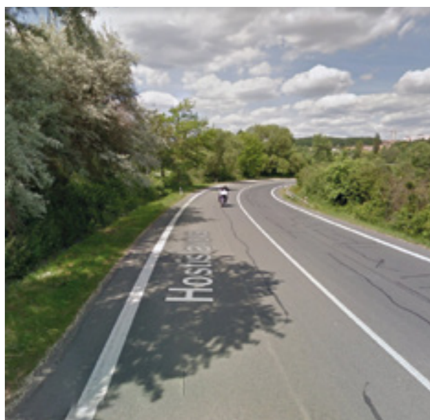
Ulice Hostislavova před zahájením výstavby.
