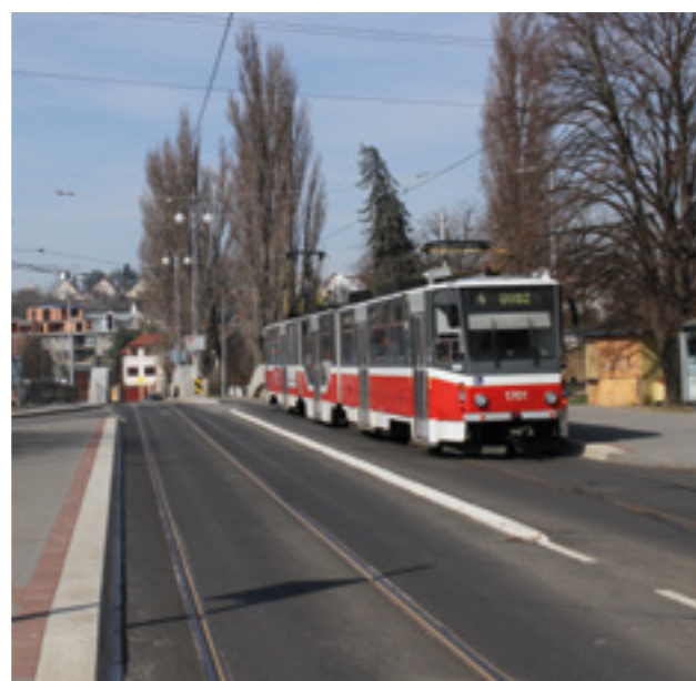
Bezbariérová úprava zastávky Maloměřický most.
