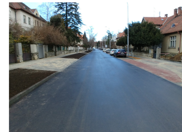
Ulice Lerchova po realizovaných opravách.
