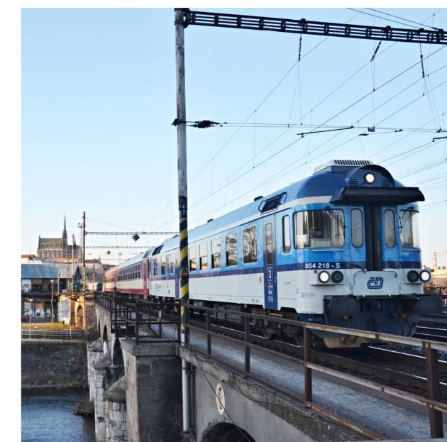
Vlaková souprava na lince S4 směřující z Brna do Zastávky a Náměstí nad Oslavou projíždí po mostech, jejichž celková rekonstrukce spojená s velkou výlukou by měla proběhnout v roce 2019.
