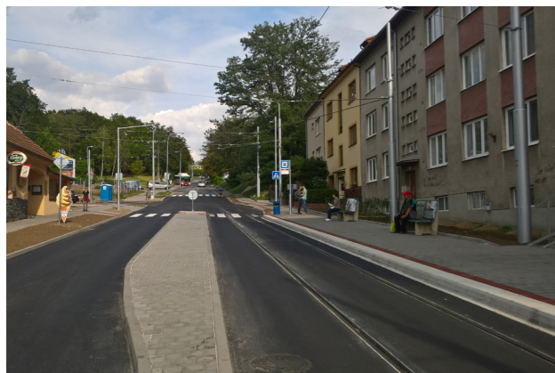
Bezbariérová úprava sdružené zastávky Juliánov.
