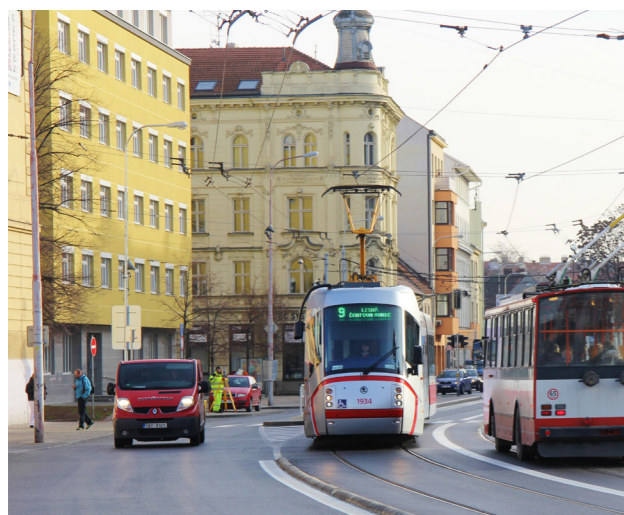
Rekonstrukce tramvajové tratě v ul. Křenová.
