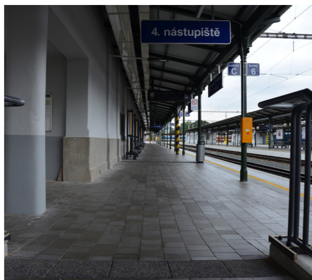
V létě 2017 byla dokončena oprava 4. nástupiště na hlavním nádraží.
