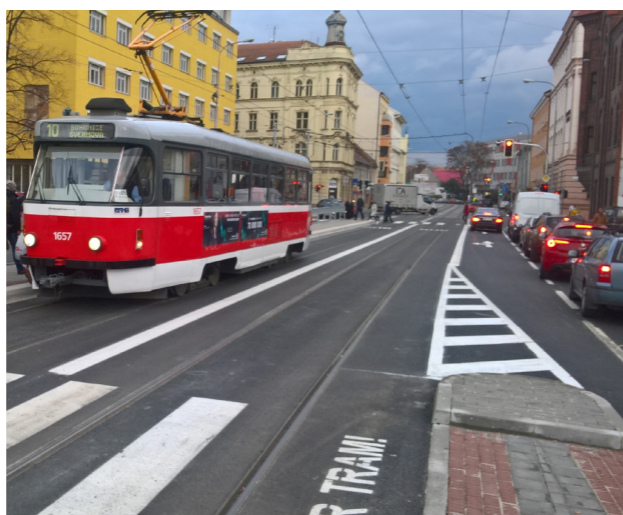
Bezbariérová úprava zastávky Vlhká na ul. Křenová.
