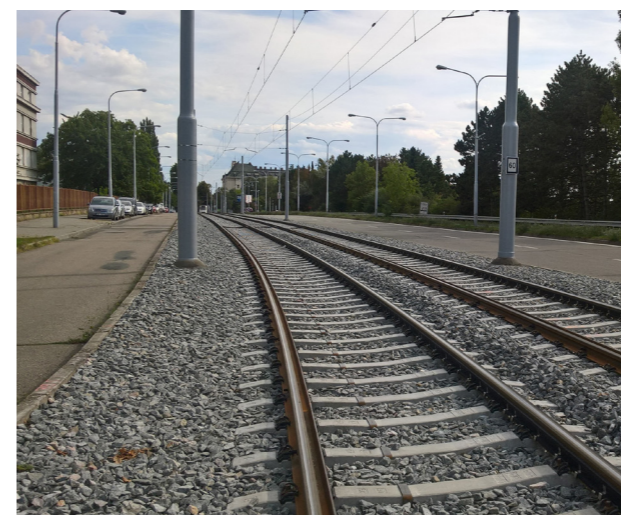
Rekonstrukce tramvajové dráhy na třída Generála Píky.
