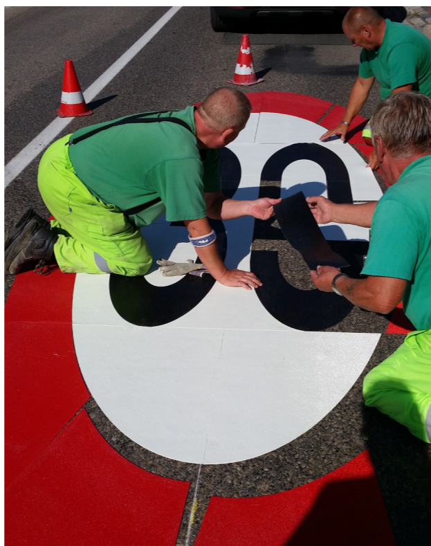
Pokládka VDZ typu Termoplast.
