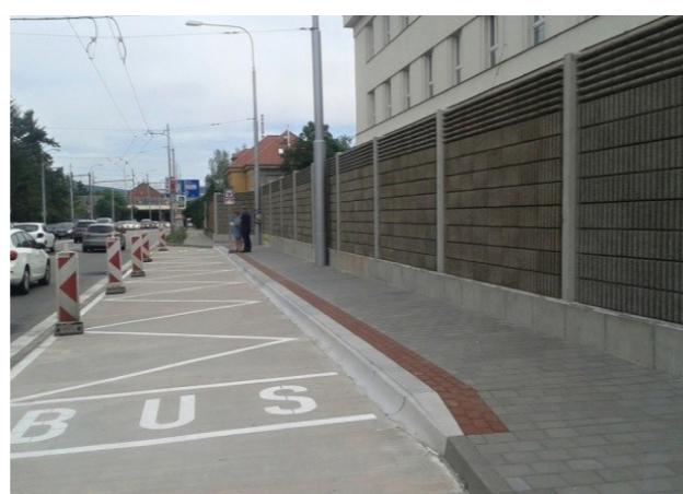
Ulice Svatoplukova po realizaci zastávkového zálivu.
