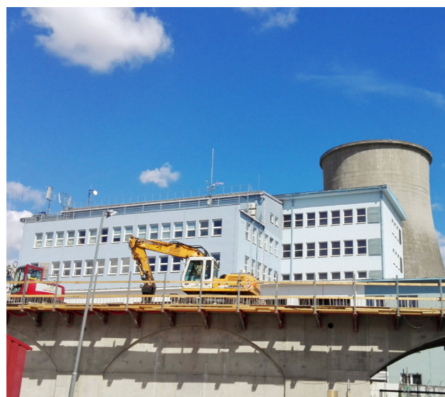
Po celé léto 2017 probíhaly opravy tzv. Pražského viaduktu, po němž přijíždí na hlavní nádraží vlaky od Blanska a Tišnova. Záběr ve směru od ulice Špitálka.
