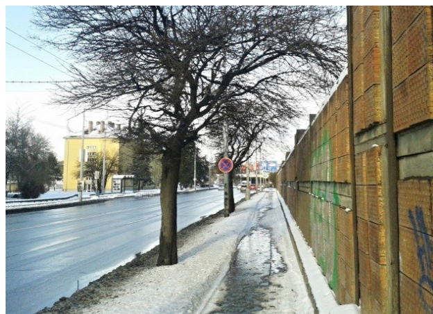
Ulice Svatoplukova před realizací zastávkového zálivu.
