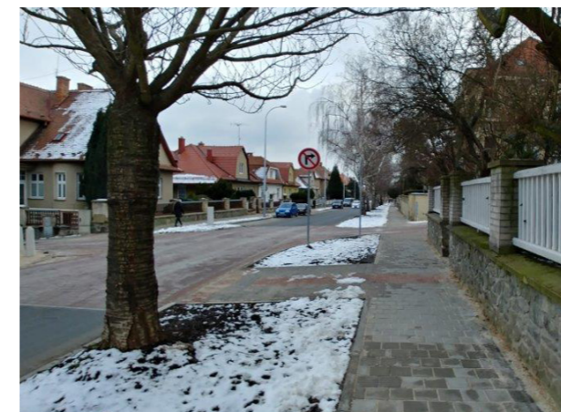
Ulice Lerchova po realizovaných opravách.
