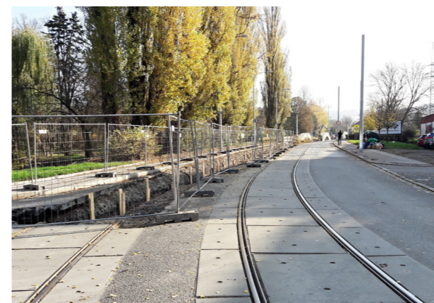
Stavební práce na ulici Valchařská.
