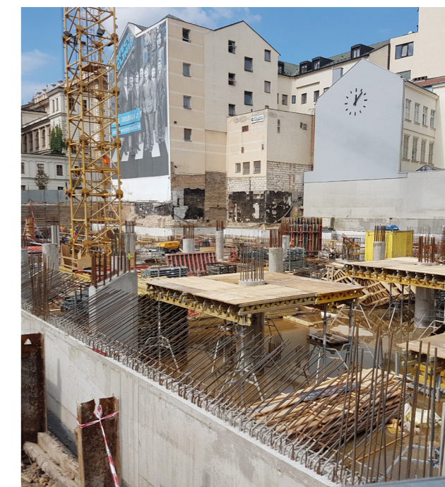
Dokončování hrubé stavby - r. 2017.
