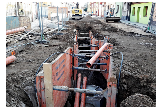
Stavební práce na ulici Valchařská.
