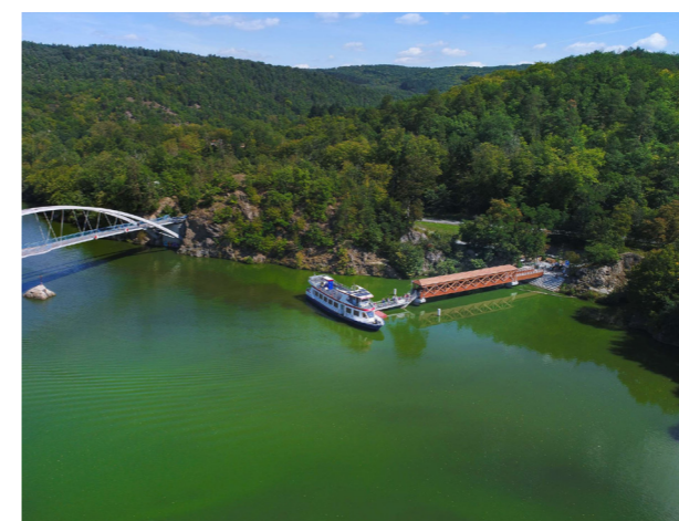
Lávka a nový bezbariérový přístav pod hradem Veveří.
