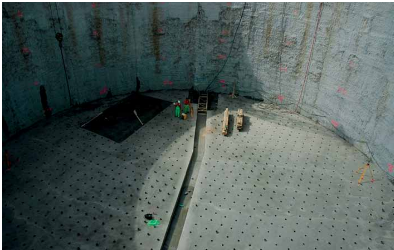
Obr. 1 pohled na dno RN před tryskovou injektáží
