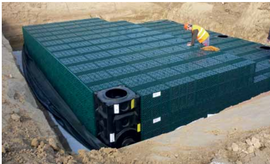
Budování retenční nádrže
