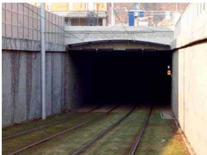
Užití tramvajového návěstidla s technologií LED na vjezdu do tramvajového tunelu Hlinky
