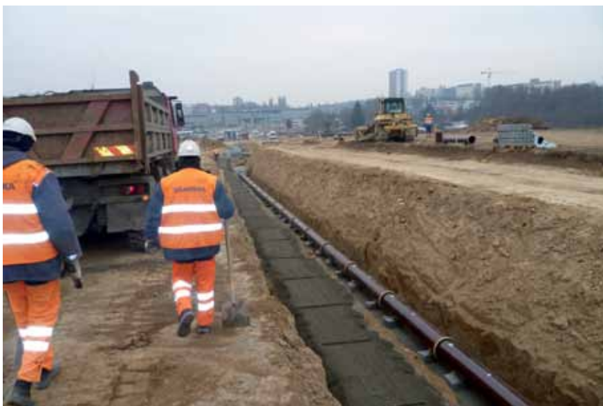
Pokládka jednotné a dešťové kanalizace
