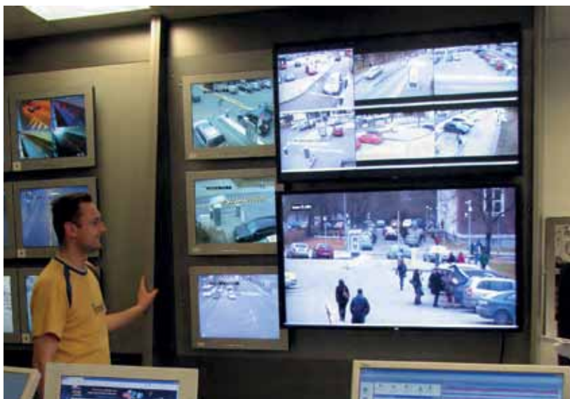
Stávající část CTD BKOM s dohledem nad provozem parkovišť se závorovými systémy
