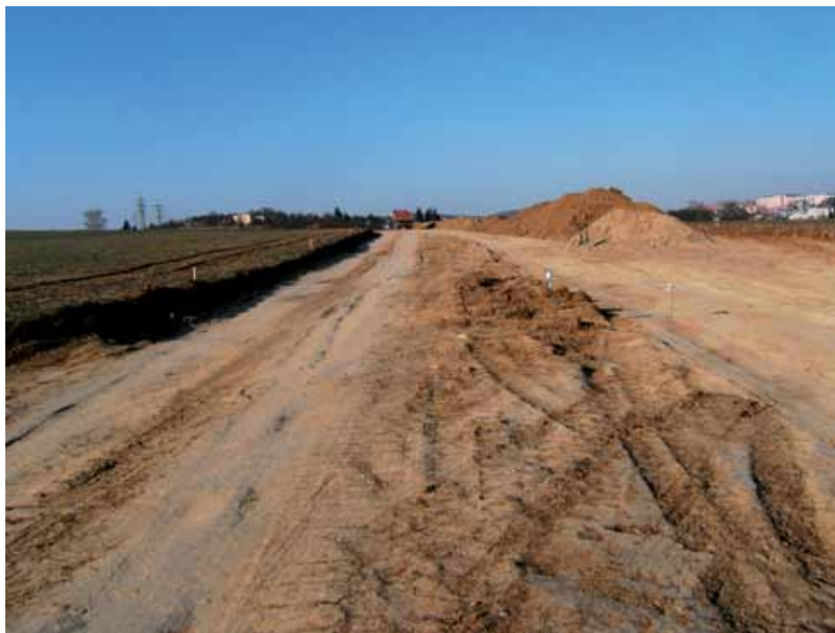
Skrývka ornice ul. Purkyňova
