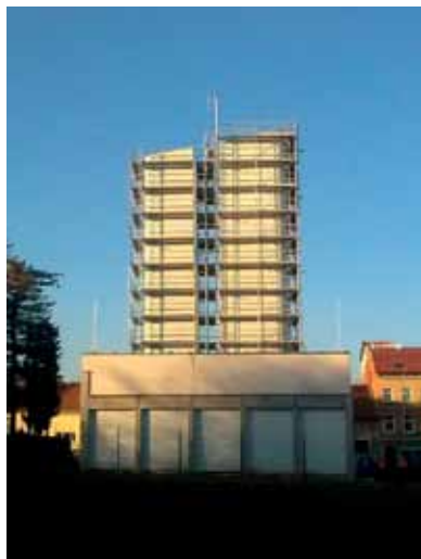
Technologické centrum tunelu na ul. Dobrovského
