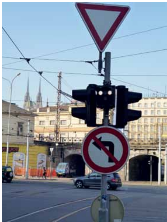
Použití tramvajových návěstidel s technologií LED na jednom z nejfrekventovanějších dopravních uzlů v Brně – křižovatce Křenová – Dornych
