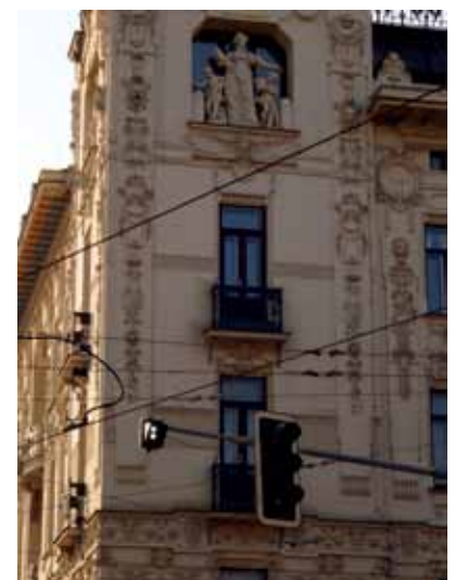
Tramvajové návěstidlo s technologií LED na křižovatce Veveří – Kotlářská
