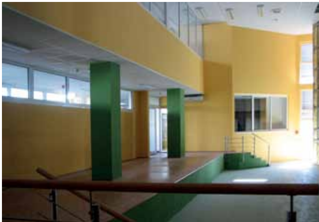
Vnitřní prostory nového sálu Centrálního technického dispečinku
