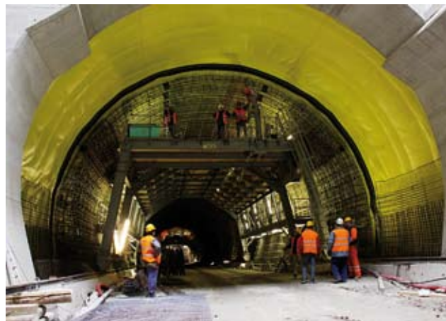
Izolace a montáž výztuže definitivního ostění tunelu
