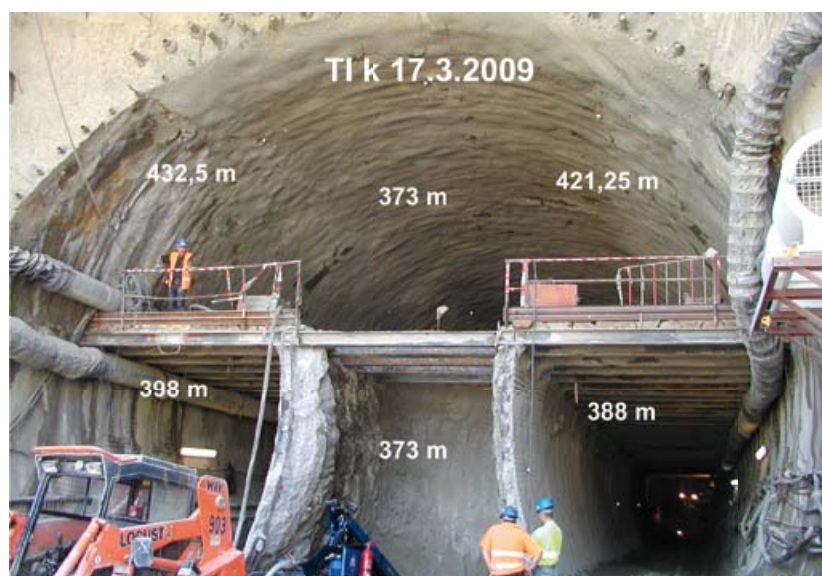
Ražba tunelu I ve směru od Králova pole – stav k 17. 3. 2009
