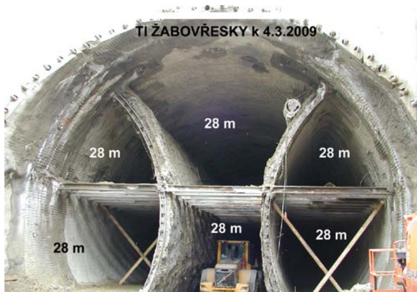
Protiražba tunelu I od Žabovřeského portálu v délce 28 m, zárodek pro přípravu překryté části tunelu – stav k 4. 3. 2009
