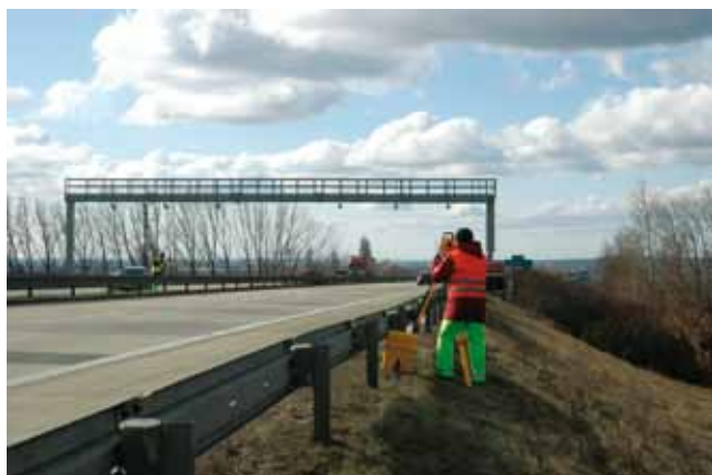
geodetické práce na akci „Mýtné na dálnicích a RK“
