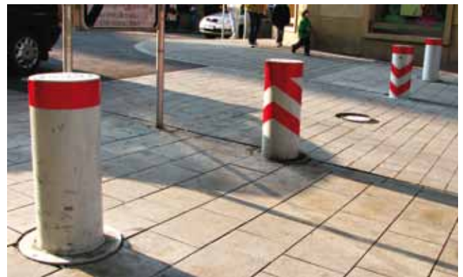
Příklad umístění automatických zádrží v profilu komunikace
